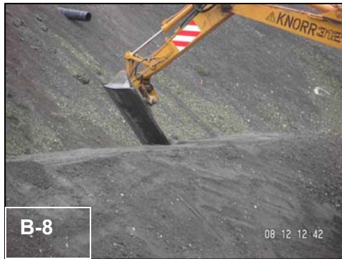
Abb. B-8: Optische Trennung der drei Testfelder mit Sperrschicht mittels Baggerschaufel (links)
