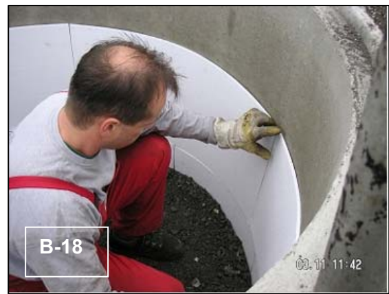
Abb. B-17: Großlysimeter (WA1 und WA2) bestehend aus zwei Betonringen (links)
