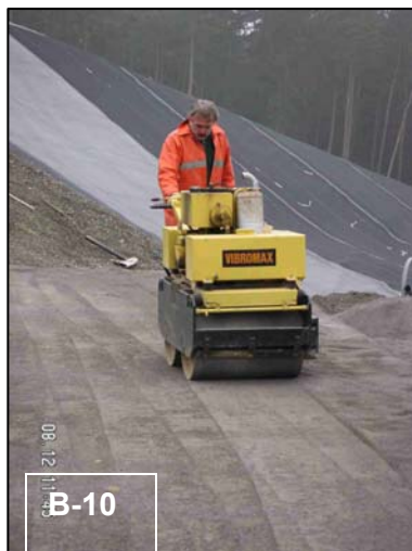
Abb. B-10: Verdichten des Schlacke- Feinkorns mittels Rüttler (links)
