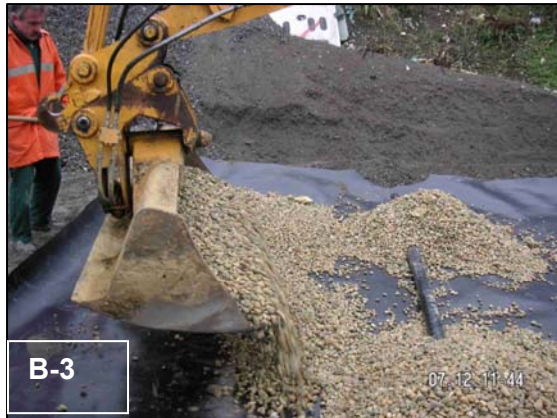
Abb. B-3: Aufbringung einer Kiesschüttung auf eine Folie, in die Kiesschüttung wurde ein Drainagerohr eingebracht (links)
