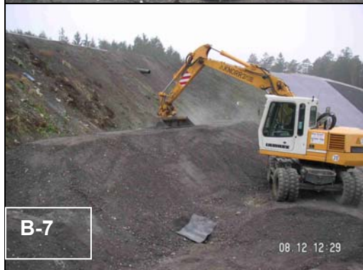
Abb. B-5: Auftürmen der MV-Schlacke zu Pyramidenstümpfen (links - oben)
