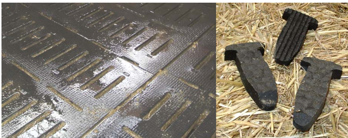
Abbildung 5 - Neu verlegte Gummimatten im Stall und Dübel
