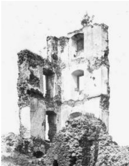
Abb. 15: Bergfried vor dem Einsturz im Jahr 1905 (Biebl 1998, S.127; Bayerisches Landesamt für Denkmalpflege, München)
