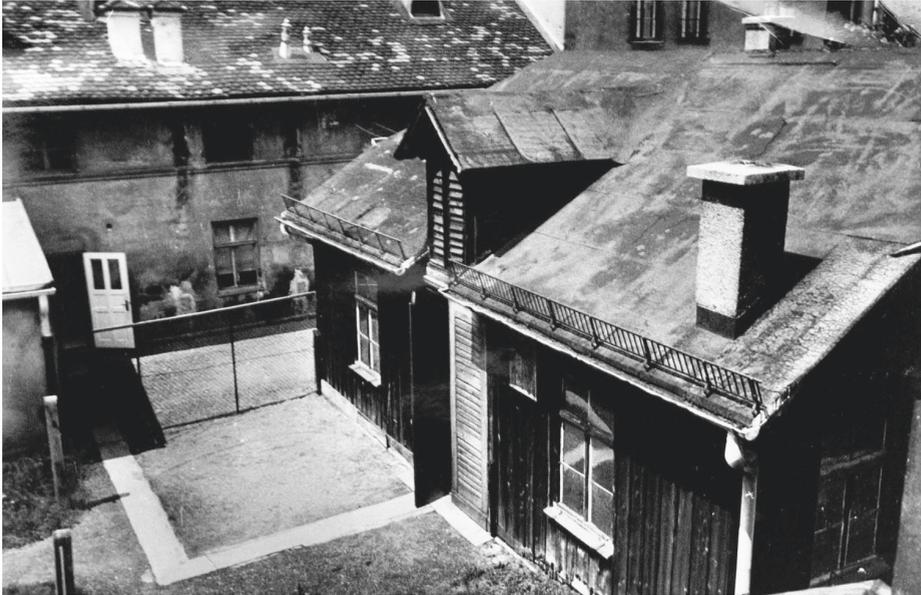
Abb. 13: Der alte Tierversuchsstall des Instituts für Tierpathologie, dessen Bretterverschlag so morsch war, dass der Stall nicht gegen Ratten und Mäuse abgedichtet werden konnte
