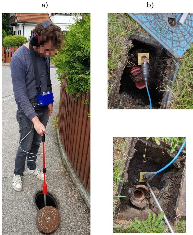
Abbildung 3.7: a) Lecksuche mit Hilfe eines Sondierstabs. Nachdem der Experte den Sondierstab auf die Hydrantenverbindung gesetzt hat, prüft er die Geräusche auf mögliche Anomalien.
