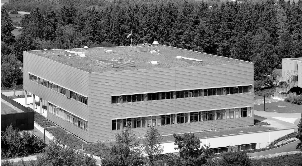
Abb. 16: Neubau Bundeswehrkrankenhausapotheke Ulm
