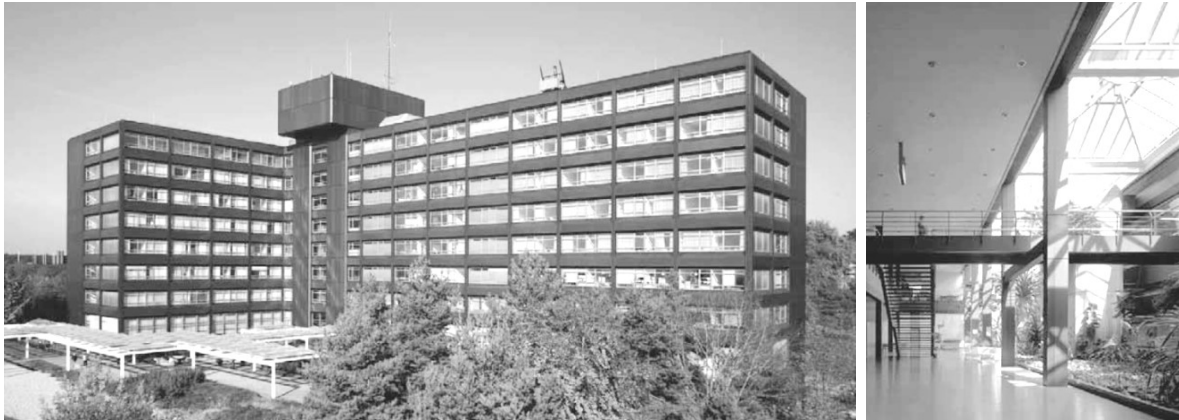
Abb. 7-8: BwKrhs Ulm, Außenansicht und Innenansicht
