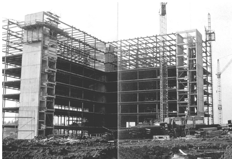
Abb. 6: BwKrhs Ulm, Stahlbaukonstruktion
