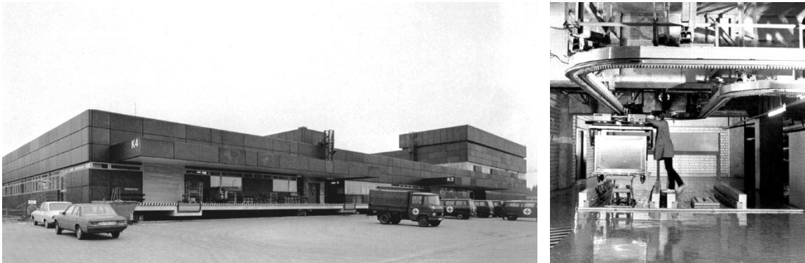
Abb. 10-11: BwKrhs Ulm, Versorgungsgebäude und AWT
