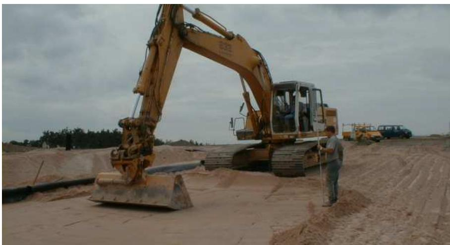
Abb. 57: Angleichen der Kapillarschichtoberfläche.
