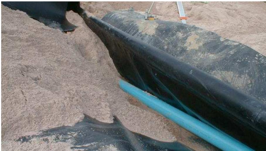
Abb. 56: Entwässerungsgraben mit Dränrohr für die Kapillarschicht.
