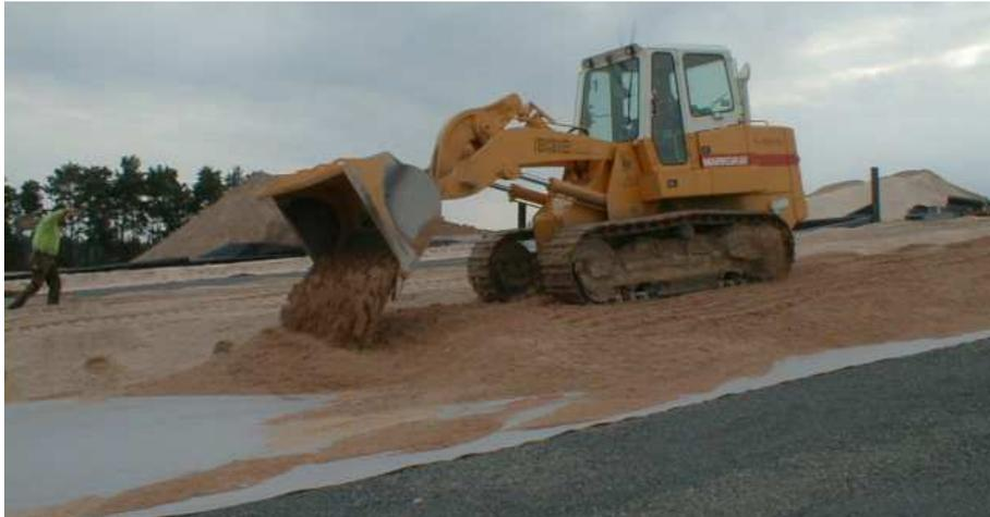
Abb. 55: Aufbringen des Kapillarschichtmaterials auf das Geotextil.
