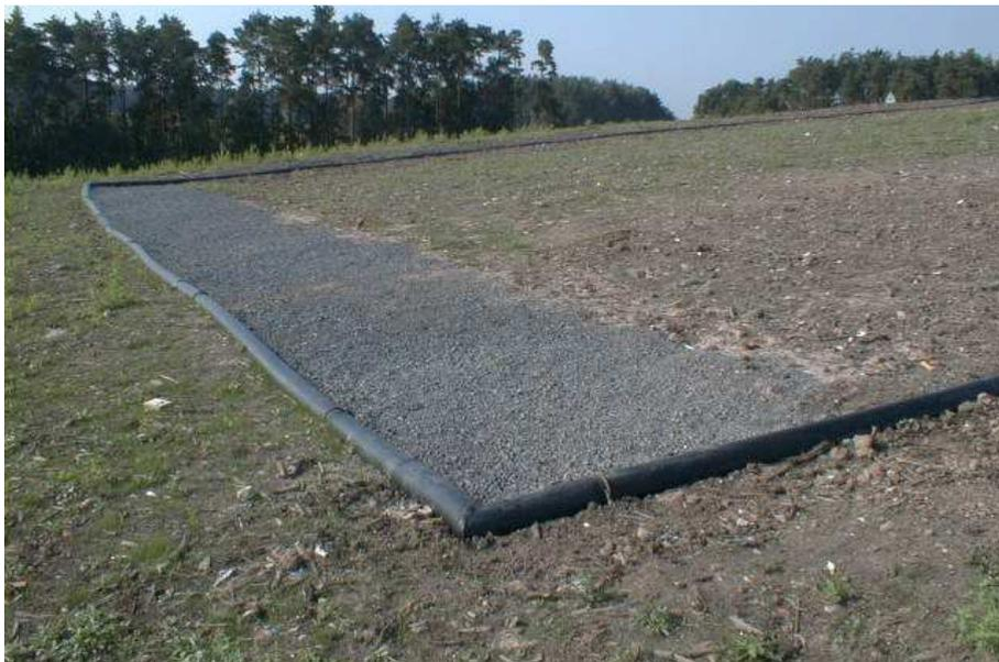
Abb. 59: Oberfläche von Lysimeter 1 mit kiesgefülltem Entwässerungsgraben kurz nach der Fertigstellung.
