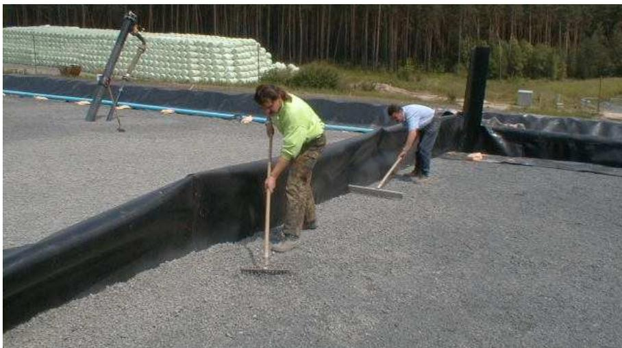
Abb. 54: Feinarbeiten zum Angleichen der Kapillarblockoberfläche.
