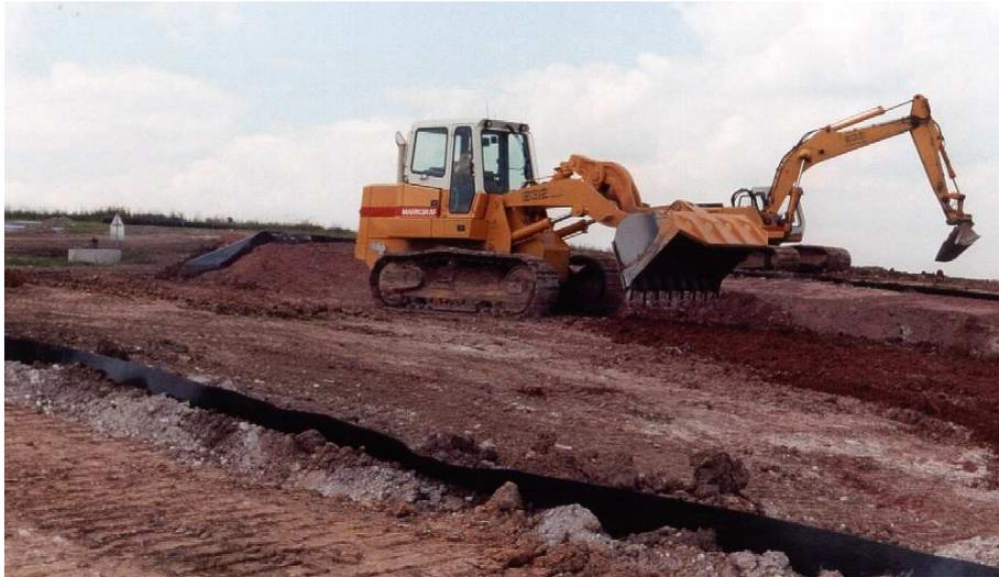
Abb. 58: Aufbringen der Rekultivierungsschicht, im Vordergrund die Lysimetergrenze.
