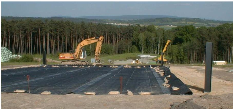
Abb. 53: Basis des Lysimeters aus sandrauher Kunststoffdichtungsbahn.
