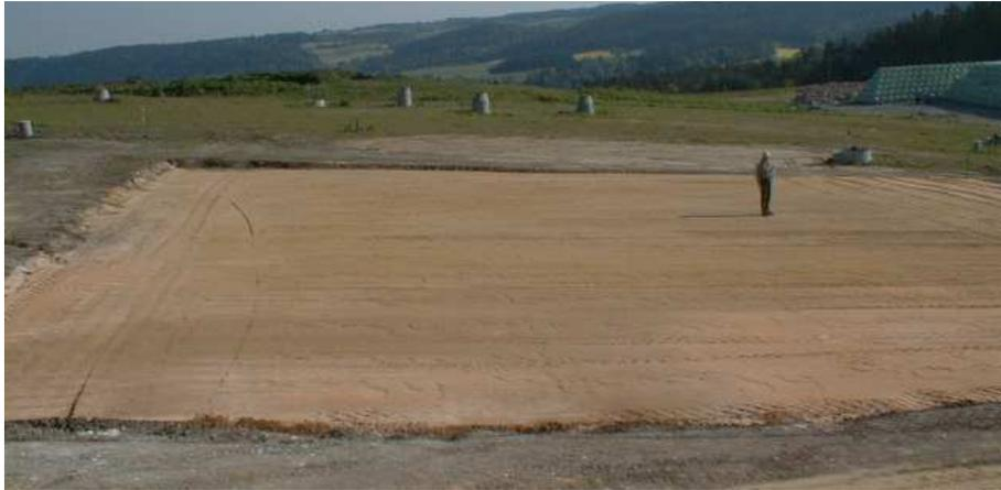
Abb. 52: Versuchsfelduntergrund mit Sandschutzschicht für die Lysimeterbasis.
