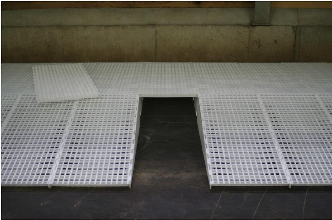
**Abb. 2: Kunststoffroste der Firma Big Dutchmann auf der Gefälleseite des Stalles unter den Rund- bzw. Nippeltränken**
