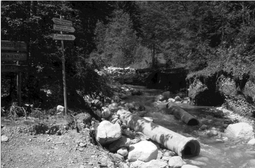
Abb. 3.1: Zerstörter Forstweg nach einem Unwetter mit intensiver Murtätigkeit im Einzugsgebiet des Schwarzenbach/Obb.
