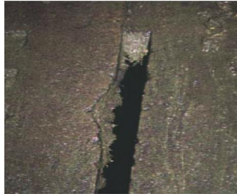
**Abb. 37** Ausgebrochene, scharfe Kante eines Spaltenbodenelements (FIEDLER, 2003f)
