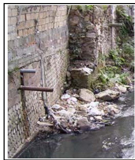
Foto 129 (links): Das teils defekte und nicht gewartete Kanalisationssystem Havannas ist verantwortlich für den Eintrag der Abwässer in die Vorfluter (Ammerl 11/2004), [vgl. Anhang Kap. 4.2/5]
