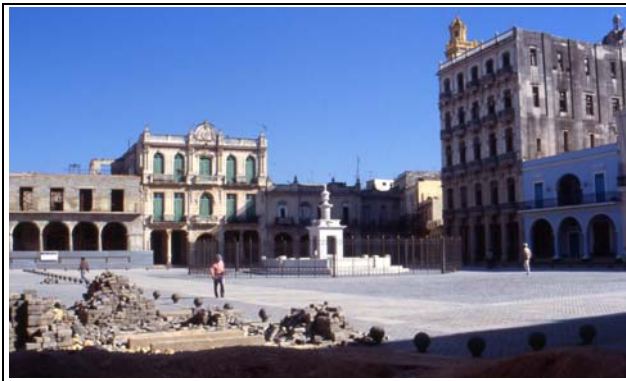
Foto 69: Verlegung des Bodenpflasters am Plaza Vieja (Ammerl 11/1999)
