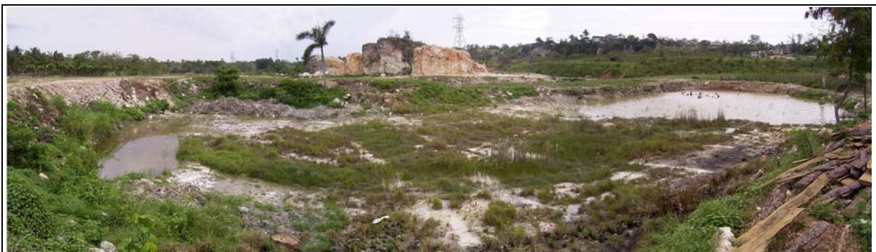
Foto 208: Panoramaaufnahme nach Westen. Mit Hilfe von Blas Roca konnten Wege und Staubecken auf dem Gelände neu angelegt werden. Im Vordergrund sieht man ein Staubecken, welches über Grundwasserquellen gespeist wird und zur Erhöhung des Retentionsvermögens des Quibú beiträgt. Im Hintergrund rechts baden bereits Kinder aus der Umgebung des Parkgeländes in einem Abschnitt des Staubeckens, welches sich kontinuierlich füllt (Ammerl 05/2005)
