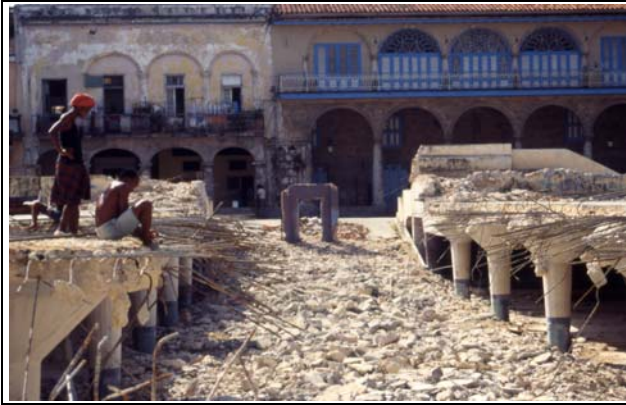
Foto 67: Abrissarbeiten der Tiefgarage, welche den Untergrund des Platzes bildete. Bewohner der Altstadt recyceln das Baustahl der Betondecke, um dieses für eigene Bautätigkeiten wiederverwenden zu können (Ammerl 09/1995)
