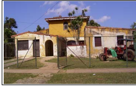
Foto 89 und 90: Im Stadtteil Siboney (Stadtbezirk Playa) befindet sich die Bausubstanz meist in einem guten Zustand (Ammerl 02/2004)
