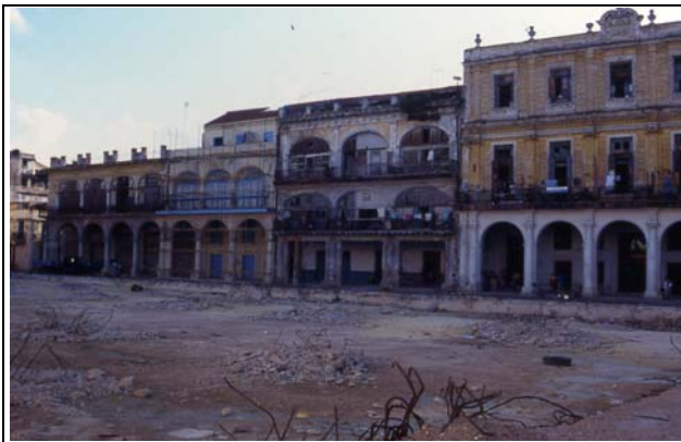
Foto 68: Nachdem die Tiefgarage entfernt worden war, wurde im Anschluß der Platz mit Bauschutt verfüllt, um den historischen Originalzustand herzustellen (Ammerl 04/1996)
