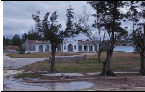
Foto 94 und 95 (oben): Typische Holzhäuser in Santa Fé an der Westküste Havannas (Ammerl 05/2003)
