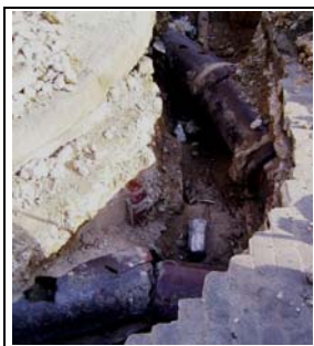
Foto 129 (links): Das teils defekte und nicht gewartete Kanalisationssystem Havannas ist verantwortlich für den Eintrag der Abwässer in die Vorfluter (Ammerl 11/2004), [vgl. Anhang Kap. 4.2/5]
