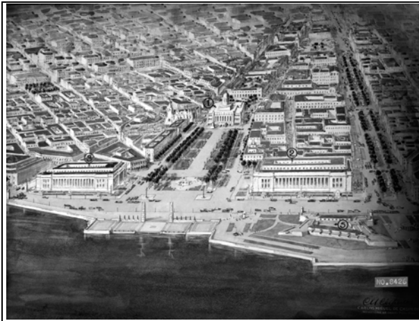
Abbildung 28: Luftbild mit Blick auf den zentral gelegenen Präsidentenpalast um 1920 (Quelle: Carlos Miguel de Cespedes, Secretario de Obras Públicas)
