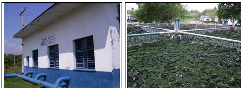
Foto 124 und 125: Die Kläranlage im EZG Quibú befindet sich im Mittellauf des Flusses und wurde Mitte der 70er Jahre gebaut. Vor allem in den Sommermonaten ist die Kläranlage wegen der zu geringen Kapazität überlastet (Ammerl 03/2002)
