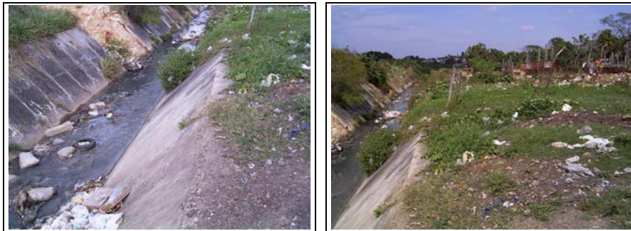
Foto 77 und 78: Parallel zur Laguna de Oxidación des biotechnologischen Komplexes im Stadtbezirk La Lisa befindet sich ein offener Kanal, in welchen die Abwässer der Biotechnologie direkt eingeleitet werden. Nach rund 100m mündet der Kanal in den Fluss Quibú (Ammerl 02/2004)
