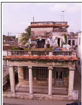
Foto 8: Säulenportal an einem Privathaus im Stadtbezirk Marianao. In der späteren kolonialen Bauphase wurden die Säulen als Repräsentationssymbole eingesetzt, die jedoch im Gegensatz zu den zentral gelegenen Stadtteilen von den Fußgängern nicht öffentlich nutzbar waren (Ammerl 02/2004)
