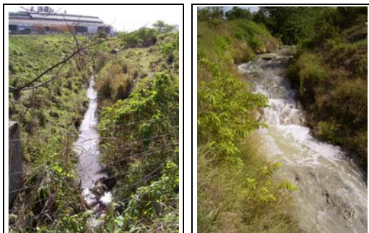
Foto 79 und 80: Parallel zu dem System der Lagunas de Oxidación an der Zuckerfabrik CAI Martínez Prieto werden die Abwässer der Fabrik in einen offenen Kanal eingeleitet. Der Kanal mündet rund 1,6km später in den Fluss Quibú (Ammerl 01/2004)
