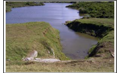
Foto 174 (rechts): Stausee La Teresita im Stadtbezirk Marianao. Aufgrund fehlender Bepflanzung am Rande kommt es im Falle von Starkniederschlägen zu Bodenerosion (Ammerl 02/2004)
