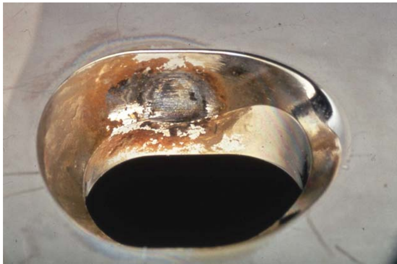
Abb. 3.1: Korrodiertes Schraubenloch mit Kratzspuren des Schraubenkopfes
