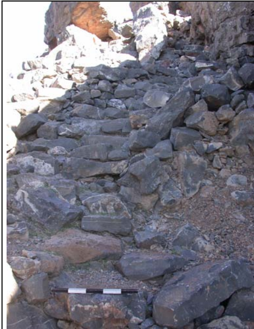
Abbildung 65: Treppe innerhalb der Festung JA079
