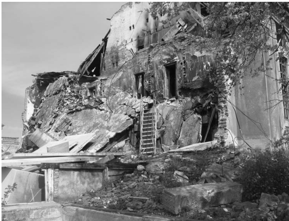
Abbildung 1: Eine der vier Schadstellen.
