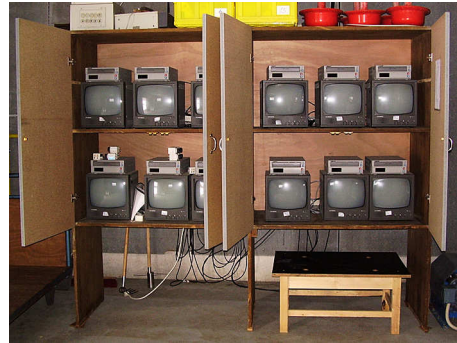
Abb. 15: Kontrollmonitore und Time Lapse-Videorecorder im Vorraum des Stalls
