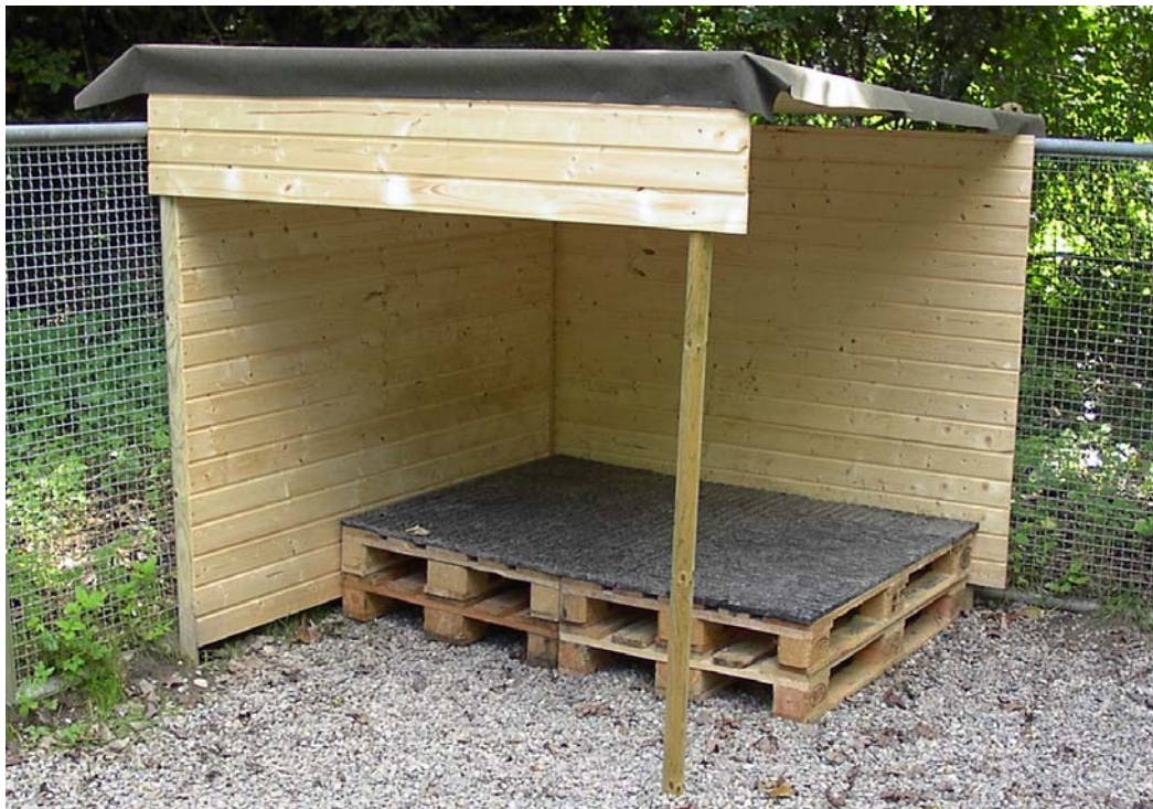
Abbildung 3-6: Unterstand im bereicherten Auslauf. Das Dach war mit Dachpatte bezogen, die Seitenwände waren wind- und regendicht. Die Europaletten waren mit einer Gummimatte bedeckt.
