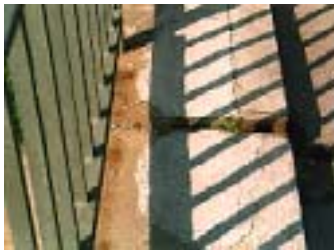
Abb. 28.1: Fuge einer Brücke
