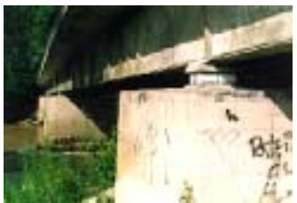
Abb. 28.2: Rollenlagerung einer Brücke
