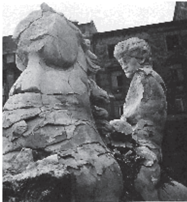
370.2.unmittelbar nach der Zerstörung 1945
