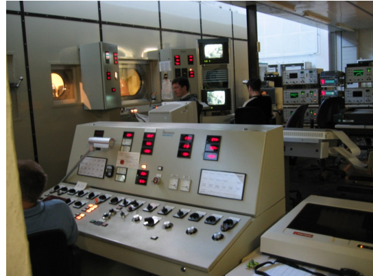
(b) Steuerungsanlage der HKS
