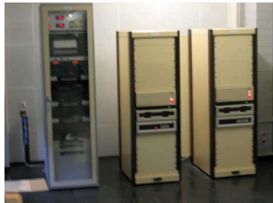
(d) Rechner zur Datenspeicherung
