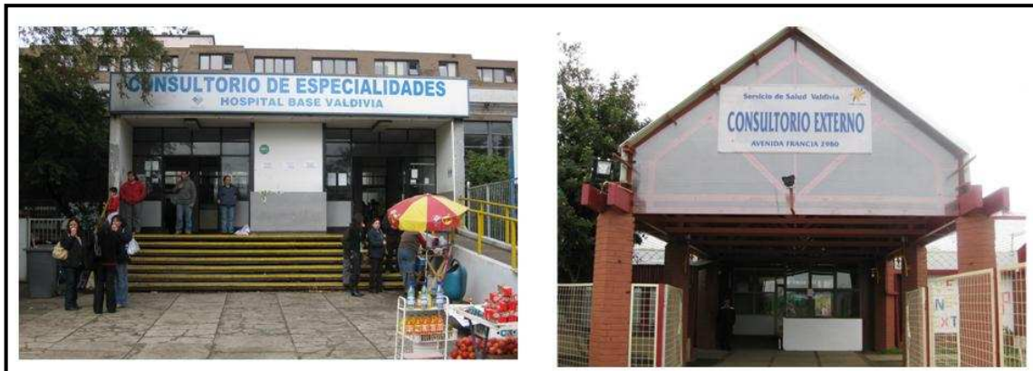
Abbildung 8: Hospital Base Valdivia und Consultorio Externo Valdivia
