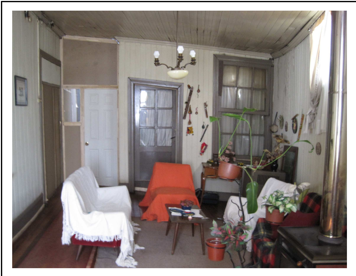
Abbildung 22: Blick in ein Wohnzimmer in Valdivia; man sieht die übliche Holzbauweise. Links an der Decke ist ein Feuchtigkeitsfleck zu erkennen, in der rechten Ecke sieht man an der Wand und an der Decke einen grau-schwarzen Schimmelfleck.
