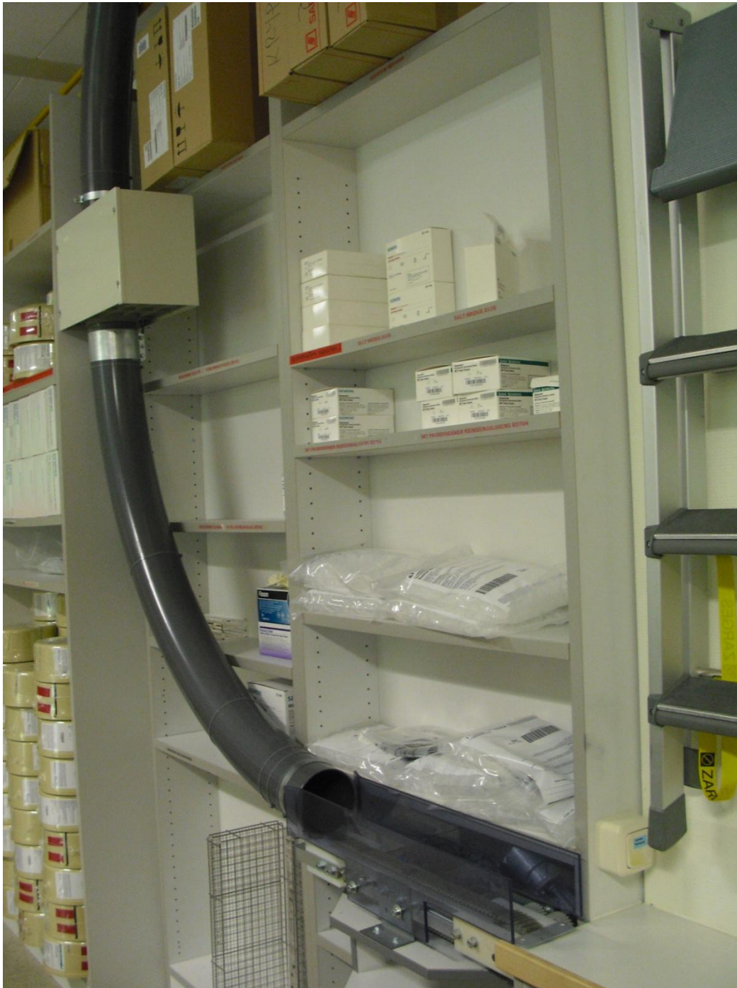
Abb. 10: Rohrpostanlage mit Auslaufbremse
