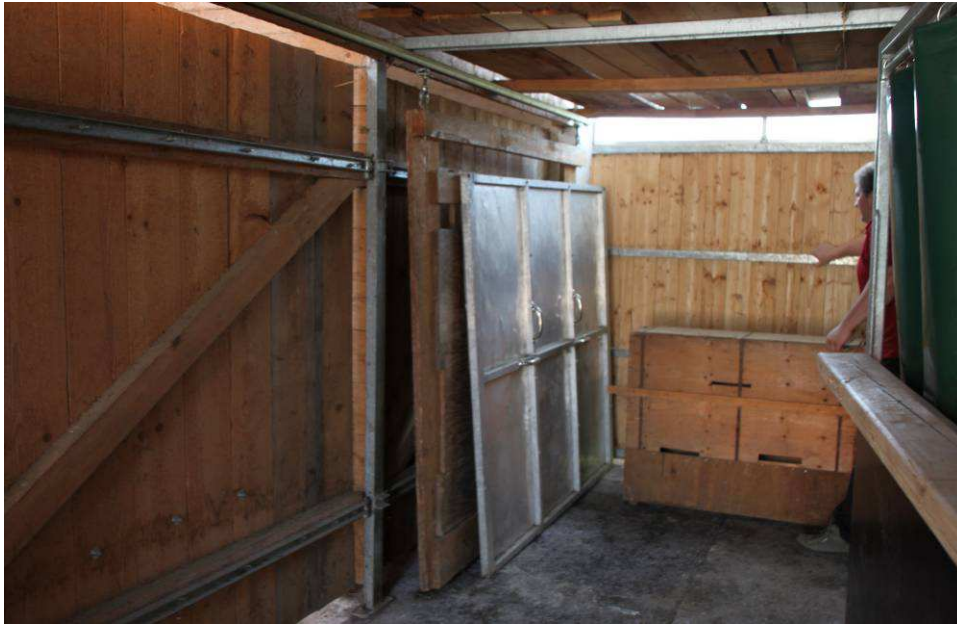
Abbildung 4: Trennelemente und Schiebetüren zum sicheren Verbringen der Tiere in die Nachbarboxen und zur sicheren Kontaktaufnahme zu den Tieren
