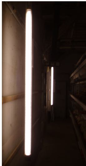
Abbildung 18: Foto der verwendeten Stablampen (Osram, Lumilux ® Warmwhite)
