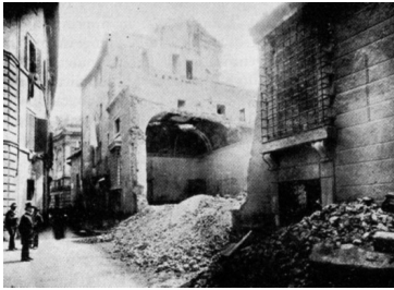
Abb.40: Palazzo Bini während der Abbrucharbeiten (aus: Pietrangeli, Rione V – Ponte, Bd.III, S.13)
