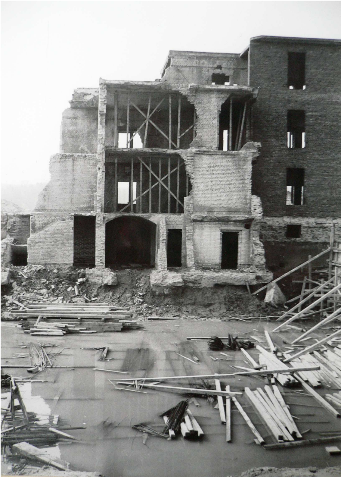
Ansichten der Gebäuderuine in Osnabrück vom Mai 1965
