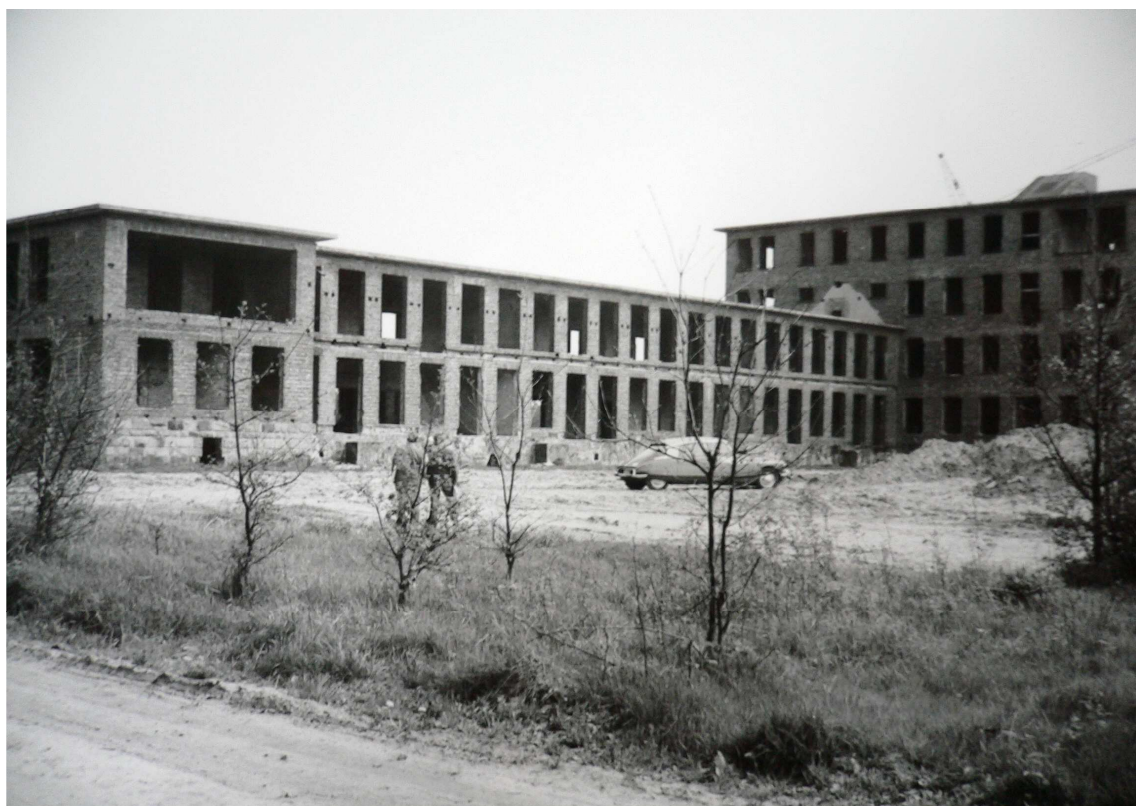
Ansichten der Gebäuderuine in Osnabrück vom Mai 1965
