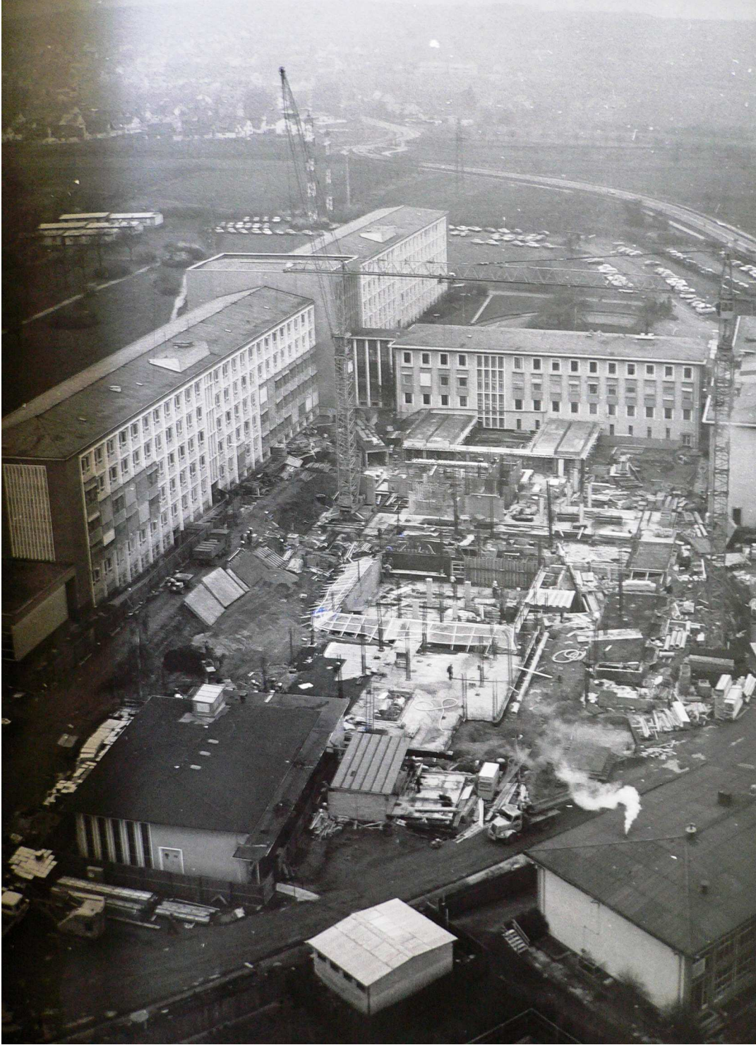
Neubau des Operationsgebäudes am Bundeswehrzentral Krankenhaus Koblenz, März 1980
