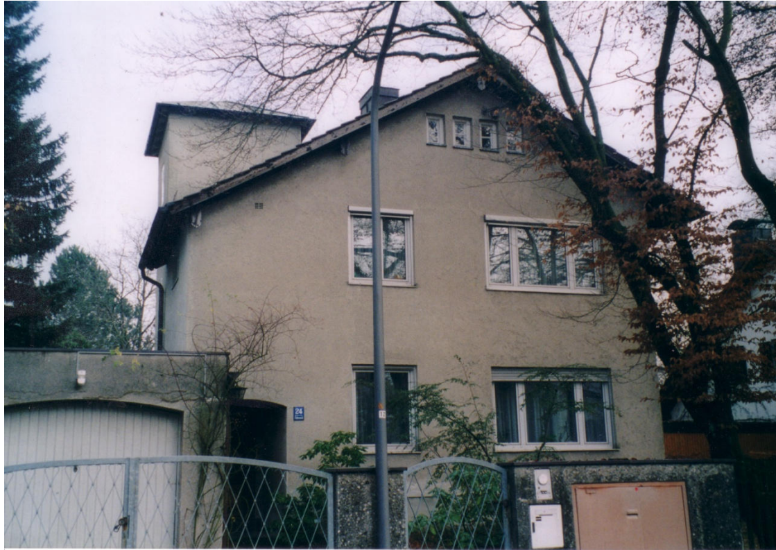
Bild 4: ehemaliges Wohnhaus von Maria Schug-Kösters in Pasing
