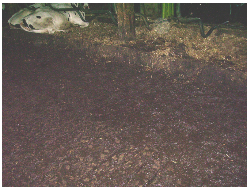
Abbildung 2 – Stark verschmutzter Betonspaltenboden im alten Stall
