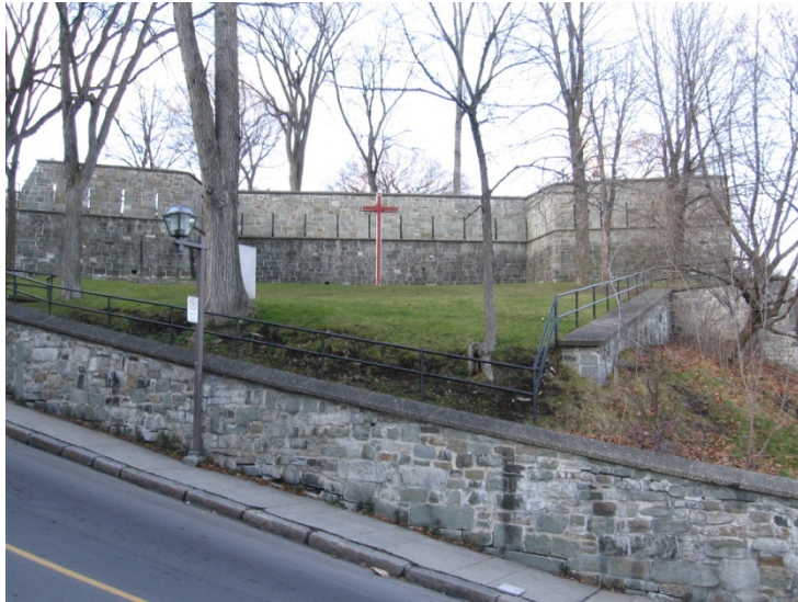
Abbildung 12.96: Nördliche Befestigungsanlage beim Parc Montmorency von der côte de la Montagne aus gesehen
