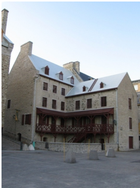
Abbildung 12.21: Blick auf die Maison Leber vom Marché Finlay aus
